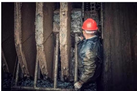
污水处理厂工人抢修滤布滤池系统
