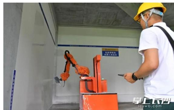
(6月15日，望城区国欣·云境府项目工地上，工人操作室内喷涂机器人在紧张忙碌。)
