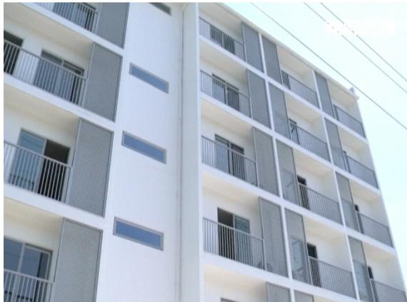
这栋造型简约时尚的建筑就是远大魔方公寓，它是一栋6层模块建筑，建筑面积约3938平方米。该建筑采用远大魔方集成模块建筑技术，95%以上工作由工厂制造，实现4天主体完工、30天精装交付入住。
